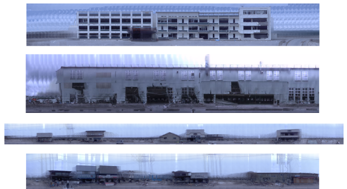
Fig. 13 : 車載カメラの多視点画像を元に作成した被災地街路のパノラマ画像。
