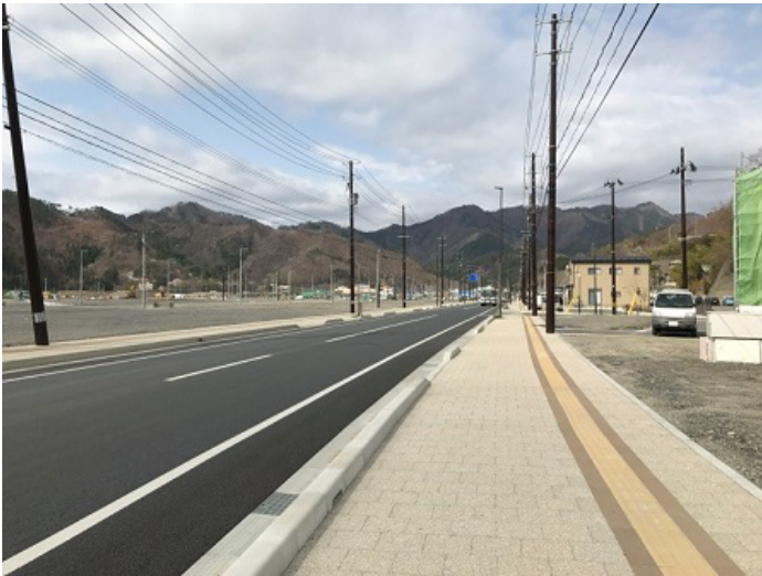
Fig. 5: 工事が進む大槌町町方地区（2017年4月筆者撮影）
