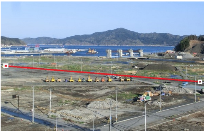
Fig. 3: 建物解体後の大槌町町方地区：赤線より手前側が土地区画整理地区（2014年5月筆者撮影）
